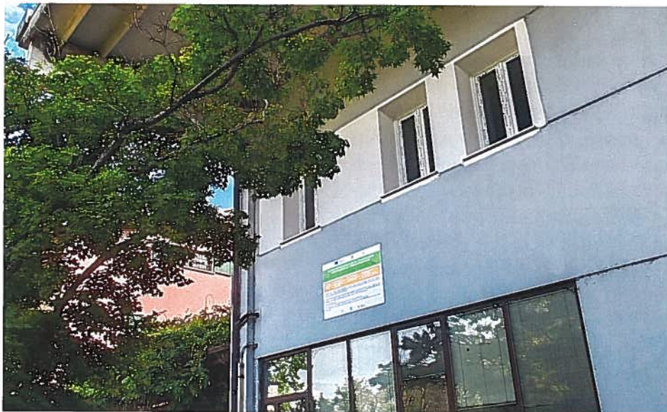
GLI APPARTAMENTI DI VIA TREPOLA
